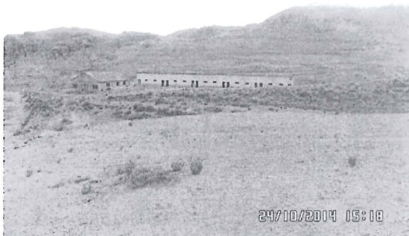
Fotografía N° 21. Vista fotográfica de los ambientes de campamento III y el almacén ubicados en el punto con coordenadas de ubicación Datum UTM WGS 84 N: 8545606, E: 490569 en la cual se observa que los ambientes han sido construidos con calaminas y estructuras metálicas.
