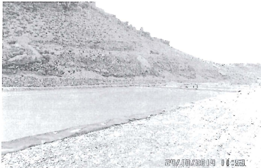
Fotografía N° 41. Hallazgo N° 02. En el punto de coordenadas Datum UTM WGS 84 N: 8545112, E: 490953, correspondiente a la bocamina B-10 se observó que el agua es canalizada hacia otras pozas para tratamiento previo a su descarga en el río Yuracyacu.
