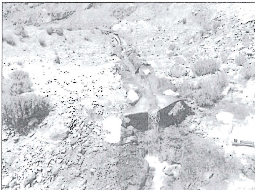
Fotografía N° 44. Hallazgo N° 03. Punto de vertimiento ubicado con coordenadas de ubicación ubicado en el punto con coordenadas Datum UTM WGS 84 N: 8544986, E: 491081, no se encuentra aprobado en el instrumento de gestión ambiental.
