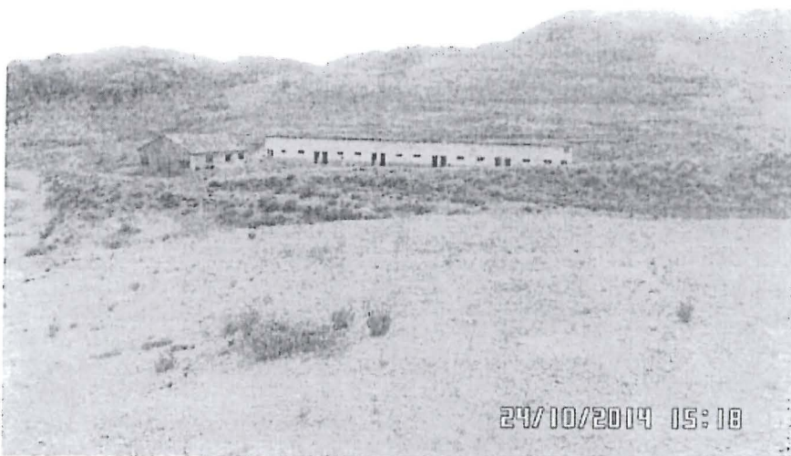
Fotografía N° 37. Hallazgo N° 01. Vista fotográfica de los ambientes de campamento y almacén ubicados en el punto con coordenadas de ubicación Datum UTM WGS 84 N: 8545606, E: 490569.
