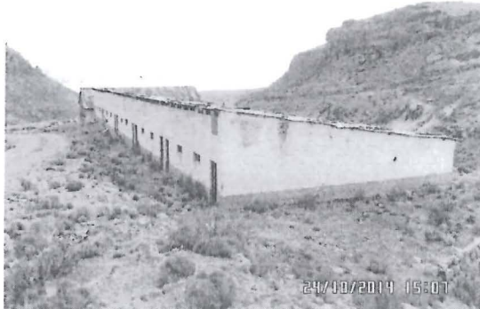
Fotografía N° 20. Vista fotográfica de los ambientes de campamento III ubicado en el punto con coordenadas de ubicación Datum UTM WGS 84 N: 8545606, E: 490569 en la cual se observa que los ambientes han sido construidos con calaminas y estructuras metálicas.
