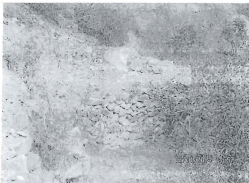
Fotografía N° 48: Hallazgo N° 4, Supervisión Regular noviembre 2014, vista de poza de sedimentación de lodos, construida en pirca de piedra y que se encuentra en la parte inferior de la plataforma Quin-4/Q-4.
