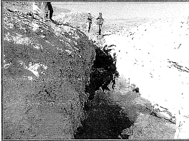
Fotografía N° 23: Mina Boliche: En la bocamina L1-B4-B, ubicada en las coordenadas UTM WGS 84: 222302E y 8923236N, existe drenaje ácido al curso natural de agua. Hallazgo 4. Se constató que no se realizó las actividades propuestas en el plan de cierre de los pasivos ambientales mineros de la unidad minera Lincuna Uno. (Acta de Supervisión – Componentes verificados, ítem 16). Hallazgo 1.
