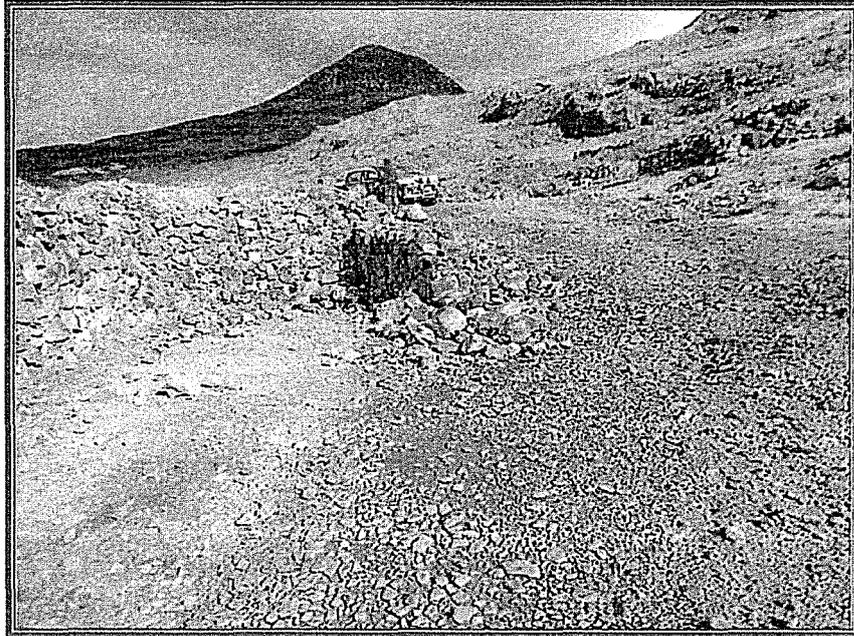
**Fotografía N° 68:** Zona Gioconda: Depósito de desmonte ubicado en las coordenadas UTM WGS 84: 224497E y 8920733N. Se constató que no se realizó las actividades propuestas en el plan de cierre de los pasivos ambientales mineros de la unidad minera Lincuna Uno. (Acta de Supervisión – Componentes verificados, Ítem 48). Hallazgo 1.
