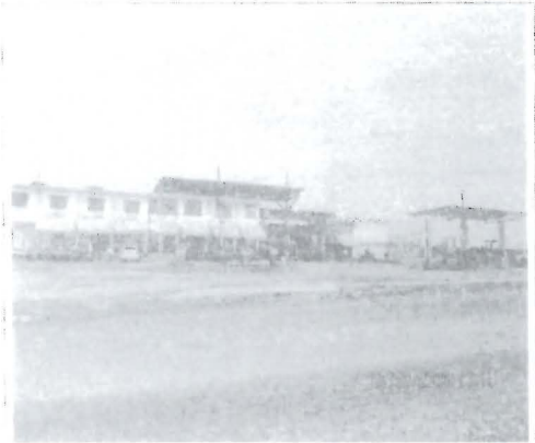
Foto N° 01: Vista Panorámica de la estación de servicios al Girasol E.I.R.L.
