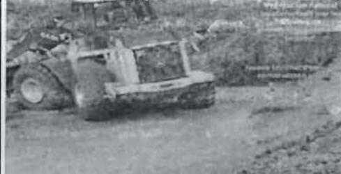
Se observa el acondicionamiento de las nuevas trincheras para relleno sanitario, así se que se aprecia que se afianza a la vegetación natural con el objetivo de mantener en la estructura, al que se dispone en las labores de control de estabilidad.
