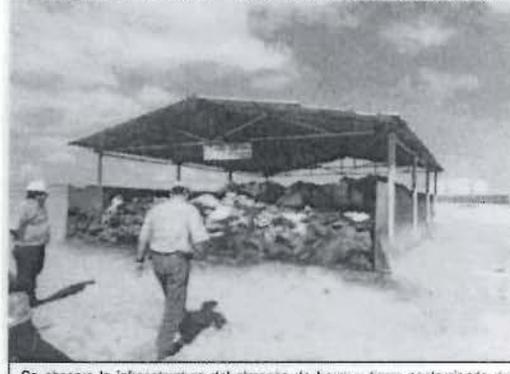
Se observa la infraestructura del almacén de borra y tierra contaminada del Terminal Bayóvar, construida con planchas metálicas soldadas y cobertura de techo, asimismo, se aprecia que en él se almacenan, en sacos de rafia, tierra impregnada con hidrocarburos los cuales por deterioro y manipulación han derramado sus contenidos afectando parte de suelo de la parte frontal del almacén, que no cuenta con sistema de contención.
