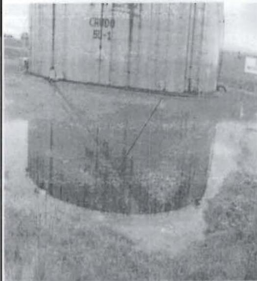
Vista del Tanque N° 1, se observa el área estanca no impermeabilizada y parte cubierta por hierba; canaletas pluviales y caja de pasos están obstruidas. Se observa un espejo de agua, formado por agua de lluvia.
