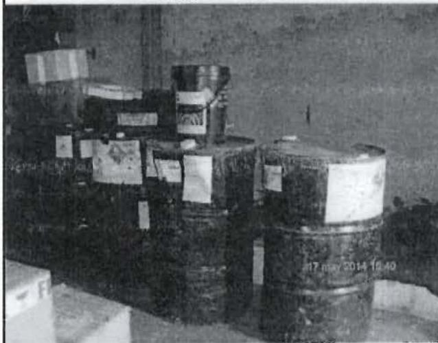
Vista interna del Almacén A, ubicado en la Estación 1 del ONP. Se observa cuatro (04) cilindros de Tetracite (3Me4Bx) Demulsifier, los mismos que están sentados sobre la base de concreto. No se observó sistema de doble contención de dichas sustancias químicas.
