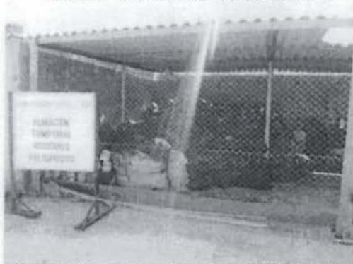
Se observa la infraestructura del almacén temporal de residuos peligrosos del terminal Bayóvar, cuenta con piso de concreto, sardinel de contención, cobertura, cerco y señalización, pero también se observa la disposición de los residuos al granel sin contenedores.
