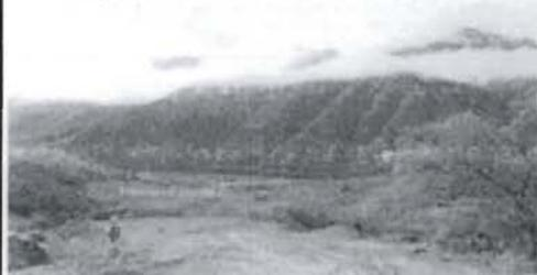
Se observan las trincheras en uso, siendo cubiertas con material existente proveniente de las obras de acondicionamiento del nuevo relleno sanitario, se aprecia que el cierre de las trincheras no cuenta con drenaje de gases y la cobertura final no fue diseñada con la impermeabilidad correspondiente.
