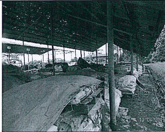
Fotografía N° 2.115-A: Almacén de químicos de perforación-Corrientes. Se observa la parte posterior del almacén de químicos de perforación N° 01, se aprecia químicos sólidos en sacos, dispuestos en parihuelas de madera sobre losa de concreto y próximas al canal de drenaje abierto, el techo del hangar está deteriorado con filtraciones 30 .
