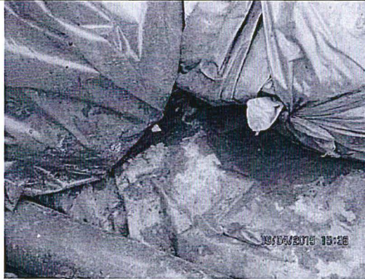
Fotografía N° 2.100-A: Área de segregación de residuos-Bayro. Se observa que los residuos contenidos en bolsas de plástico y expuestos a los agentes ambientales, estaban generando lixiviados los cuales se depositaban sobre la manta plástica y discurría sobre él hasta el suelo.
