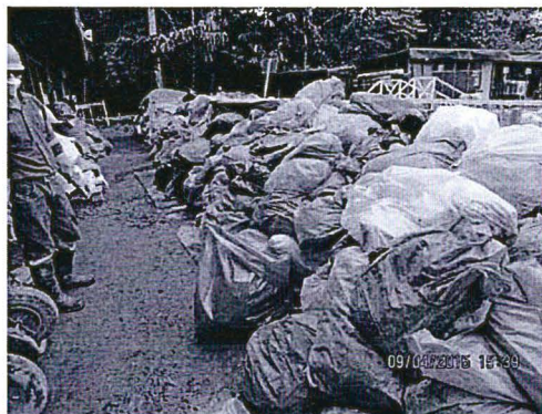
Fotografía N° 2.100-B: Área de segregación de residuos-Bayro. Se observa el área de segregación de los residuos, en la que se aprecia que los residuos se encuentran almacenados sobre plásticos directamente en el suelo, no cuenta con sistema de contención y recuperación de lixiviados, los residuos están en bolsas de plásticos frágiles y no aptos para almacenar residuos.
