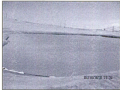
Fotografía N° 24. Vista de la Poza de agua ubicada al suroeste de la Relavera Pampa Chocón 1, la poza se encuentra construida en suelo sin revestimiento. COORDENADAS UTM WGS84: 8313792N, 477324E. ZONA 18. Hallazgo N° 3.
