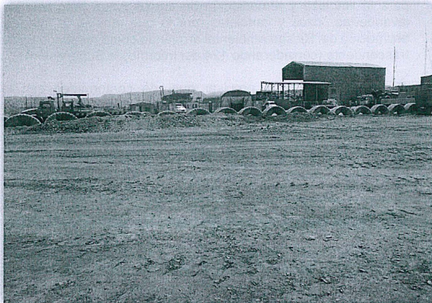
Imagen 07. Zona de taller de camiones, y equipos auxiliares.
