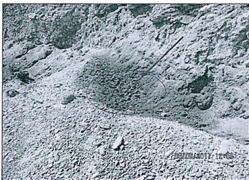
Fotografía N° 66. Vista de la filtraciones ubicado aguas abajo del deposito de relaves Pampa Choclón, se observa el suelo humedo al pie del talud del acantilado.
