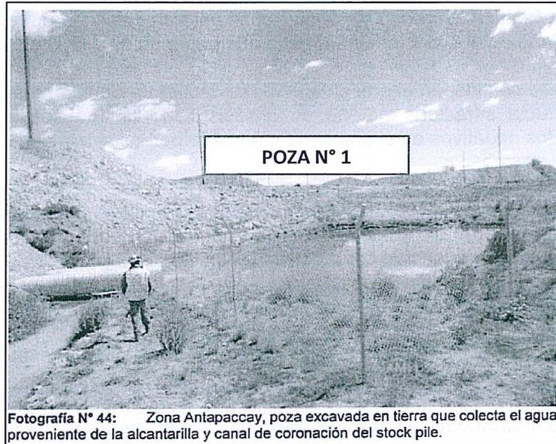
Fotografía N° 44: Zona Antapaccay, poza excavada en tierra que colecta el agua proveniente de la alcantarilla y canal de coronación del stock pile.
