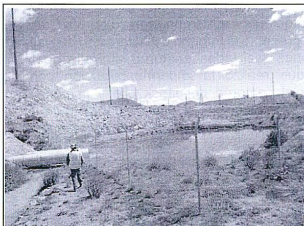
Fotografía N° 44: Zona Antapaccay, poza excavada en tierra que colecta el agua proveniente de la alcantarilla y canal de coronación del stock pile.
