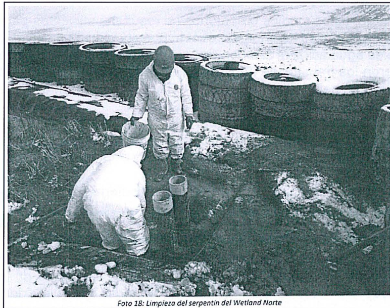
Foto 18: Limpieza del serpiente del Wetland Norte
