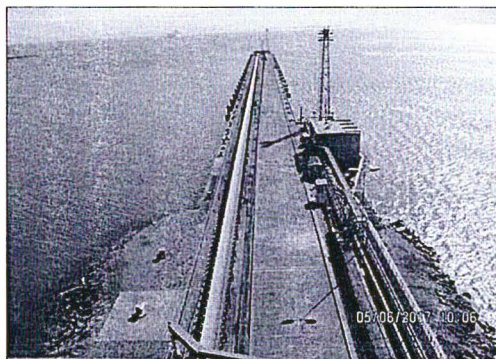
Fotografía N° 53. Vista del muelle de embarque construido de concreto, se observa una faja transportadora para el transporte de concentrado.
