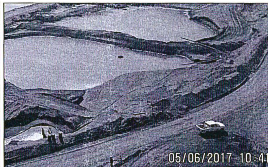
Fotografía N° 73. Vista del sistema de tratamiento de las cochas Bartlett, paso del flujo proveniente de la poza N° 1 a la poza N° 3.
