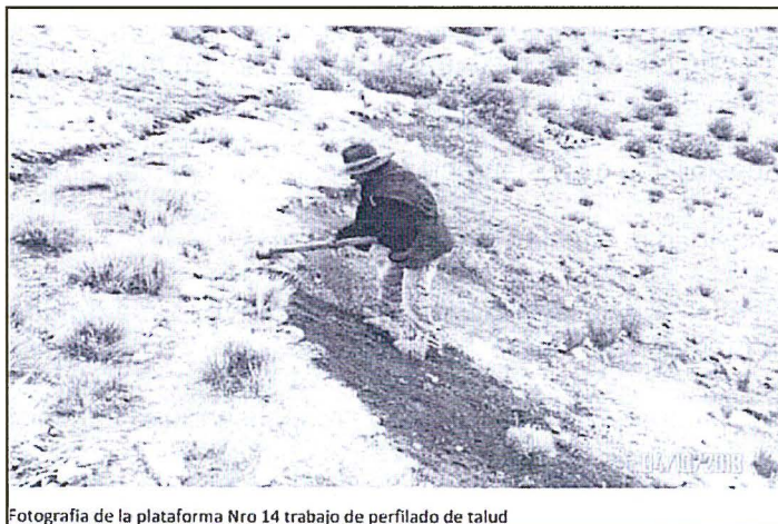
Fotografía de la plataforma Nro 14 trabajo de perfilado de talud
