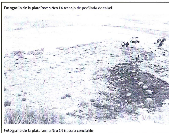
Fotografía de la plataforma Nro 14 trabajo concluido
