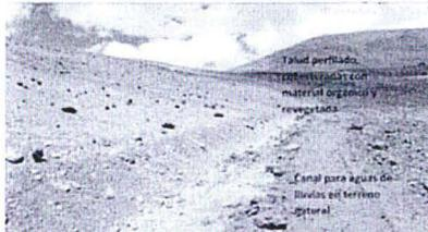
Fotografía N° 8. Se observa en la imagen talud de la zona observada por OEFA, la misma que se ha cubierto con material orgánico (Top Soil), así se aprecia la germinación de plántulas. COORDENADAS UTM WGS 84 E 307756, N 8314073.
