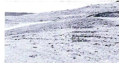
Fotografía N° 10. Se observa en la imagen talud, la misma que se ha cubierto con material orgánico (Top Soil), así como colocado de semillas nativas. COORDENADAS UTM WGS 84 E 307701 N 8314102.
