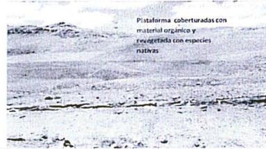
Fotografía N° 5. Se observa plataformas y bancos perfilados, en los mismos que se colocó capa de material orgánico (Top Soil) y posteriormente se esparcieron semillas de lichi. COORDENADAS UTM WGS 84 E 307569 N 8314249.
