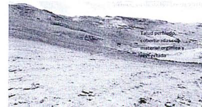
Fotografía N° 9. Se observa en la imagen talud, la misma que se ha cubierto con material orgánico (Top Soil), así como colocado de semillas nativas. COORDENADAS UTM WGS 84 E 307701 N 8314102.
