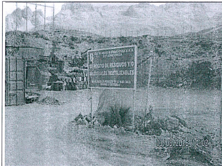
Fotografía N°66. Almacén de residuos reutilizables: Componente ubicado en la zona 18L con coordenadas UTM WGS84 E 315623 N 8826234. Vista en donde se observa el ingreso al almacén, el cual cuenta con áreas para la disposición de cilindros, chatarra entre otros.
