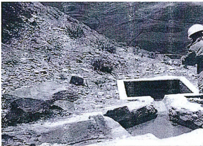
Foto 2: Ruta de tubería enterrada desde Yolanda al Nivel 3810, para el tratamiento de las filtraciones de agua que se generan en la bocamina Yolanda.
