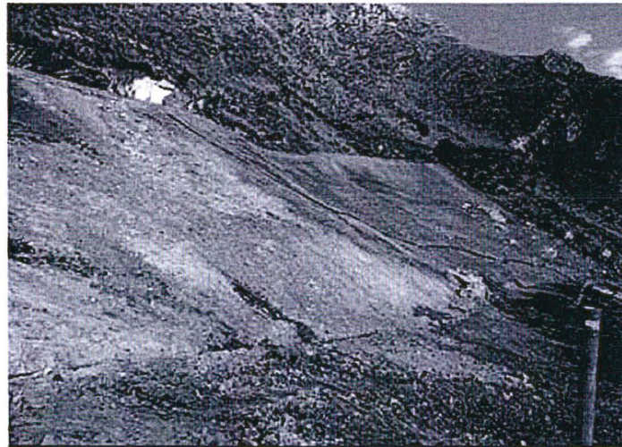
Foto 4: Retiro de desmonte del Botadero HX-2200 hasta llegar al terreno de fundación, donde se aprecian arcillas de color rojizo
