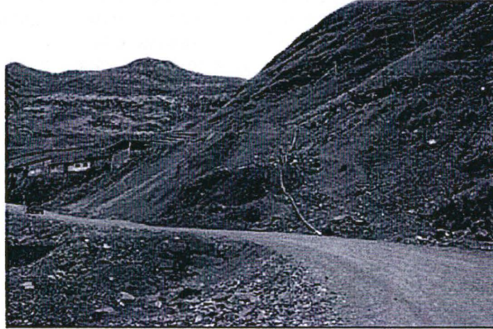
Foto 3: Retiro de desmonte de la base del Botadero HX-2200
