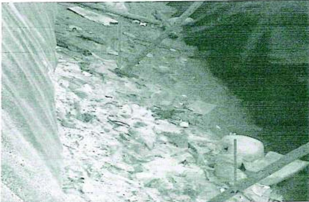
Vista fotográfica N° 07: Zanjas de disposición de residuos sólidos industriales. No cuentan parámetros de diseño aprobados por la autoridad competente. Obsérvese que la geomembrana no tiene costura vulcanizada, los tubos de "aireación" o "respiradores" no aplican los fines técnicos normados para el control de lixiviados hacia el subsuelo. Ref: de acuerdo al Art 7 de la Ley General de RRSS y art 85 del Reglamento de la LGRRSS(UTM: 501780E; 8554 500N)
