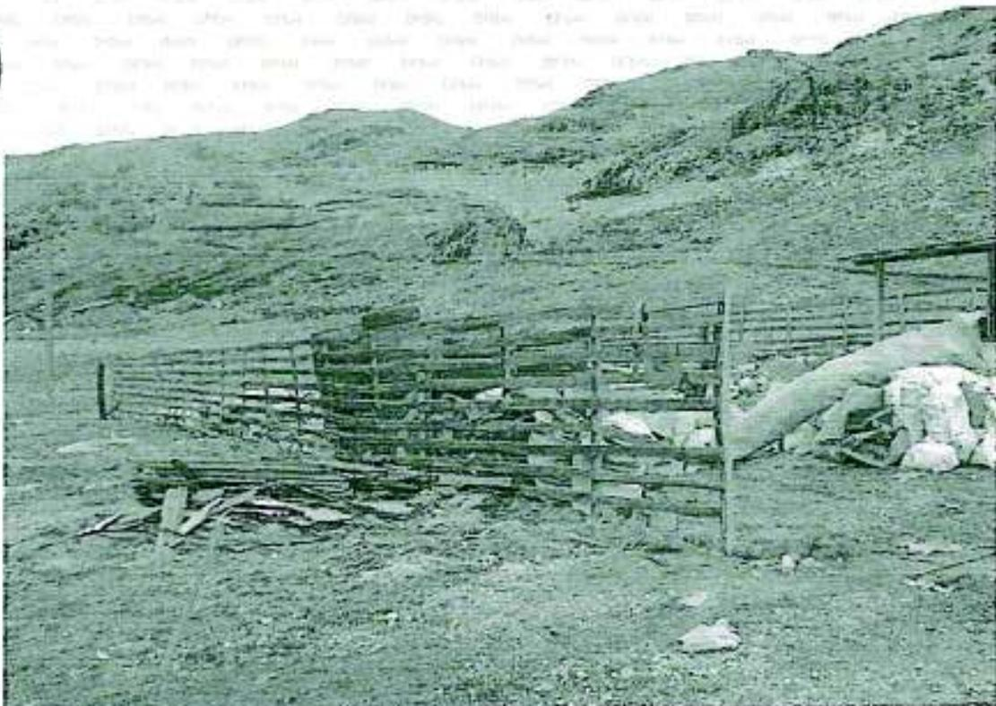
Vista fotográfica N° 09: El centro de almacenamiento y transferencia de residuos sólidos industriales no es el sitio adecuado por estar en la intemperie: a) se encuentra sin geomembrana de impermeabilización, el sitio es a cielo abierto, sin canales de coronación adecuados, los materiales no se encuentran clasificados de acuerdo su tipo y naturaleza, sin letreros debidos que impidan acceso, etc. (UTM: 501780E; 8554 500N) Ref: art. 6 del Reglamento de la LGRRSS
