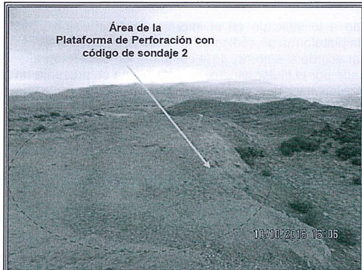
Fotografía N° 5: Área de la plataforma de perforación con código de sondaje 2, no se encontraba nivelada ni perfilada de acuerdo a la topografía del terreno. Asimismo se observó alrededor del área suelo con fragmentos de roca.
