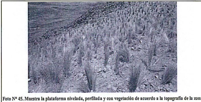
Foto N° 45. Muestra la plataforma nivelada, perfilada y con vegetación de acuerdo a la topografía de la zona
