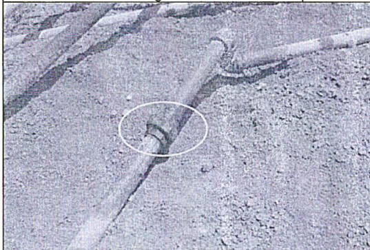
Registro Fotográfico N° 26. Pozo 12638, se observa que el personal del administrado ha realizado el ajuste de la unión universal que presentaba fuga.
