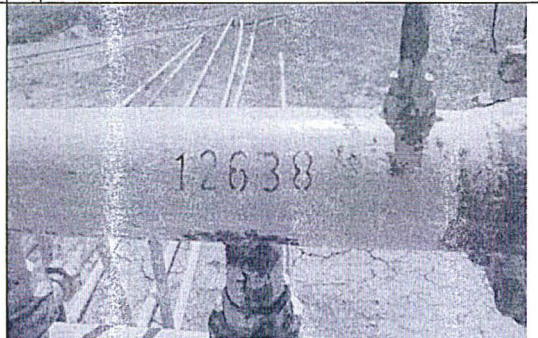
Registro Fotográfico N° 25. Pozo 12638, numeración del pozo presentada por el administrado
