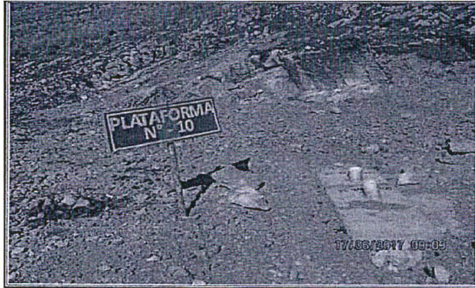
Fotografía N° 14: Se observó la habilitación de la plataforma P-10, con dos sondajes. Las dimensiones de la plataforma eran: 11 m. x 12 m, con una altura de talud de corte de 1,6 m. No se observa canal de coronación en la fotografía.
