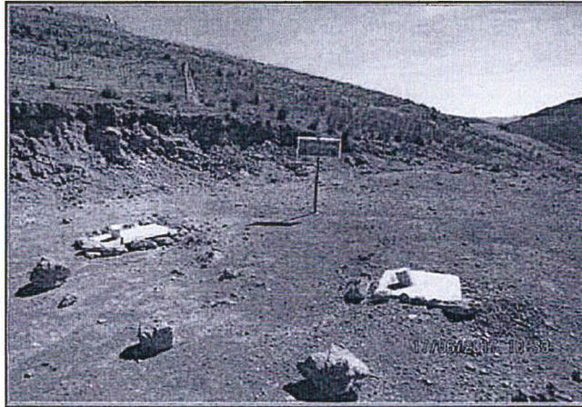
Fotografía N° 35: Se observó la habilitación de la plataforma P-11 con dos sondajes, con las siguientes dimensiones: 8,6 m x 18 m con una altura de talud de corte de 1,6 m. No se observa canal de coronación en la fotografía.
