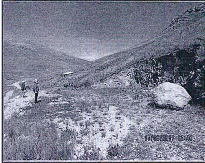
Fotografía N° 70: Se observó que se realizó la habilitación de la plataforma P-01, con dimensiones 13,5 m x 13,5 m, con una altura de talud de corte de 4 metros aproximadamente. Se observó 6 sondajes. No se observa canal de coronación en la fotografía.
