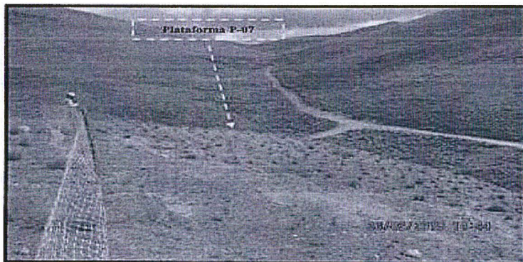
Fotografía N° 18. Incumplimientos N° 01 y 02: fotográfica del área de la plataforma P-07, el cual se encontraba perfilada acorde al entorno topográfico del terreno, presencia de ichu de la zona y cuenta con un cartel de identificación con código de la plataforma.
