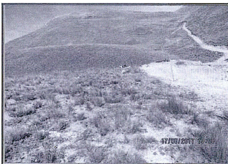
Fotografía N° 78: Se observa en la fotografía que no existe canal de coronación en la plataforma P-07.
