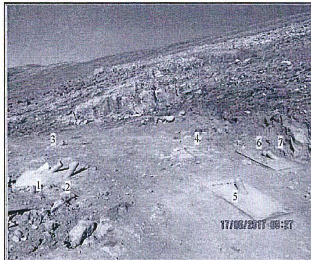
Fotografía N° 19: Se realizó la habilitación de la plataforma P-09 de dimensiones 9 m x 13 m. Se observó 7 sondajes. No se observa canal de coronación en la fotografía.
