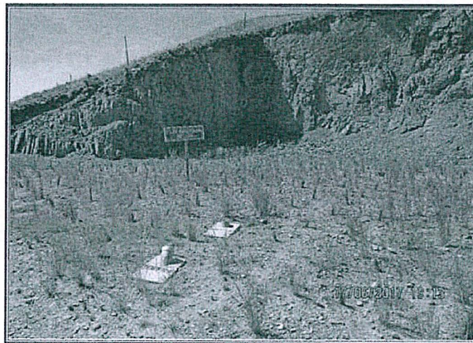
Fotografía N° 82: Se observó que se realizó la habilitación de la plataforma P-06 con dimensiones 12 m x 11 m, con una altura de talud de corte de metros aproximadamente. Se observó 2 sondajes. No se observa canal de coronación en la fotografía.
