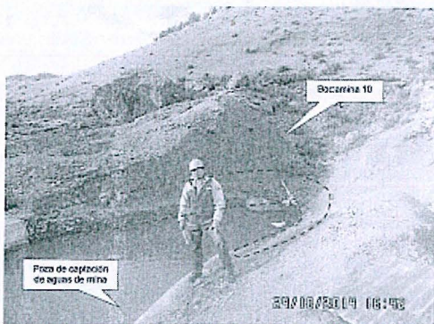
Fotografía N° 4. Vista fotográfica de la bocamina B-10, en la cual se observa que a la salida se ha dispuesto material de desmote como parte del cierre de ésta. También se puede observar que existe una poza que capta las aguas que afloran del interior de la bocamina, en la cual en uno de los extremos faltan a construir el piso y las paredes para encontrarse completamente impermeabilizada.
