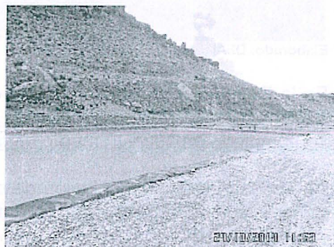
Fotografía N° 41. Hallazgo N° 02. En el punto de coordenadas Datum UTM WGS 84 N: 8545112, E: 490953, correspondiente a la bocamina B-10 se observó que el agua es canalizada hacia otras pozas para tratamiento previo a su descarga en el río Yuracyacu.
