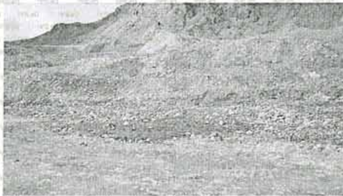
Fotografía N° 11: Depósito de desmote la Esperanza 1, la cual no cuenta con estructuras hidráulicas y sistema de subdrenaje" (folio 367)
