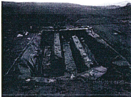
Poza serpentín en proceso constructivo
