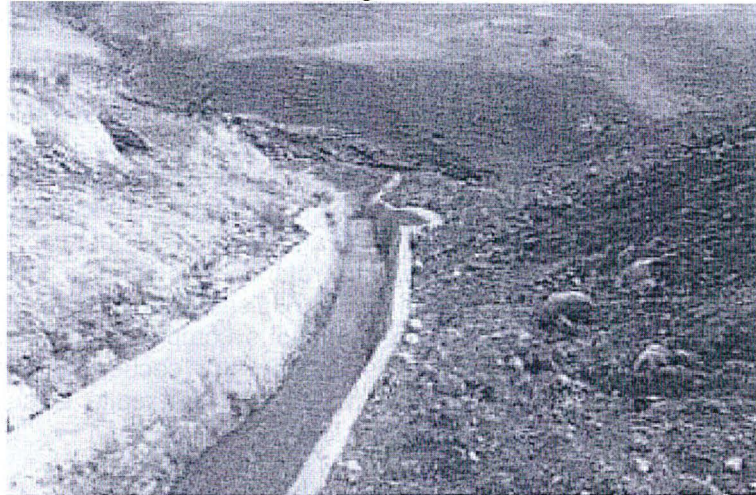
Descripción: Canal mejorado construido con mampostería
