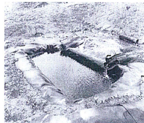
Poza nueva, más grande evita la salida de agua por rebose
