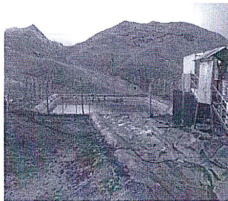
Se retiró el canal, toda el agua de contacto entra al tratamiento
