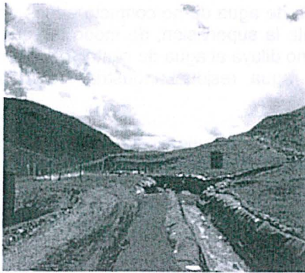
Canal y dique con el que capta el agua de lluvia.
