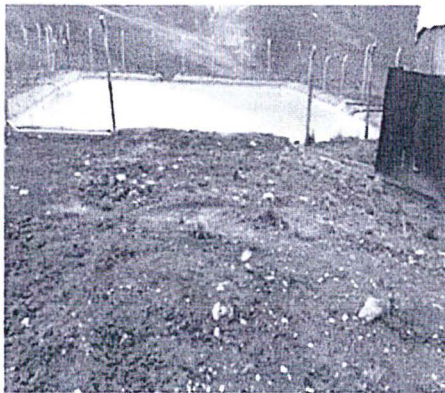
Canal de geomembrana que trasladaba agua de contacto sin tratar.
