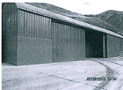
Fotografía N°8: Vista del cerco y techo del área de carguío de concentrados implementada
