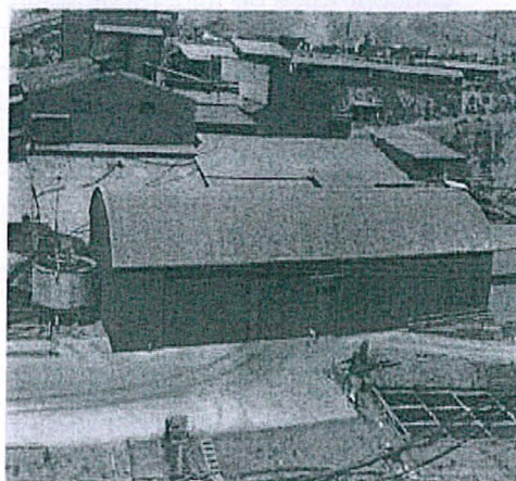
Fotografía N° 3: techo en patio de concentrados y cobertura lateral
