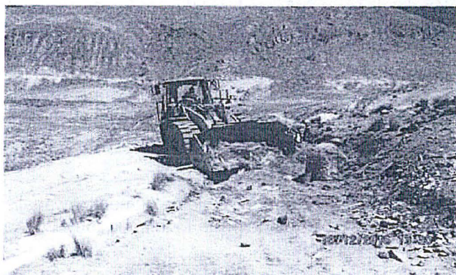
Fotografía N° 14: Retiro de ichu contaminado
