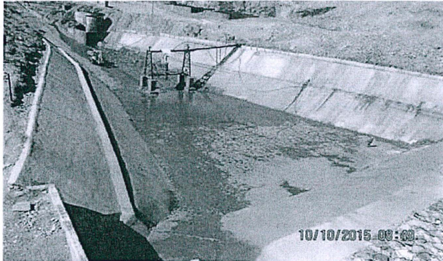
Fotografía 1.2. Vista de la poza de emergencia tomada desde la desmontera Chumpe
