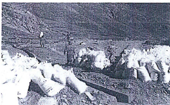
Fotografía N° 15: Acopio de sacos conteniendo suelos contaminados
