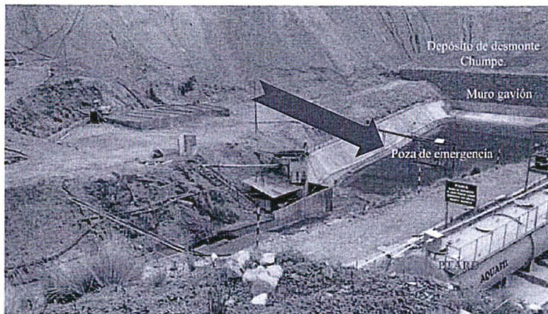
Fotografía N° 53 Otra vista de la poza de emergencia, además se observa el muro de gavión, una parte del depósito de desmonte Chumpe y la PTARD.
