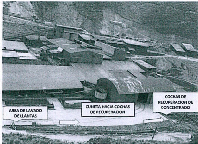
Fotografía N° 7: Las flechas indican el flujo de agua de lavado de llantas hacia las cochas de recuperación de concentrado
