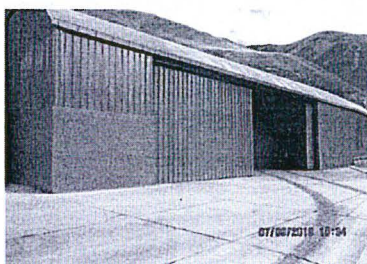
Fotografía N°8: Vista del cerco y techo del área de carguío de concentrados implementada
