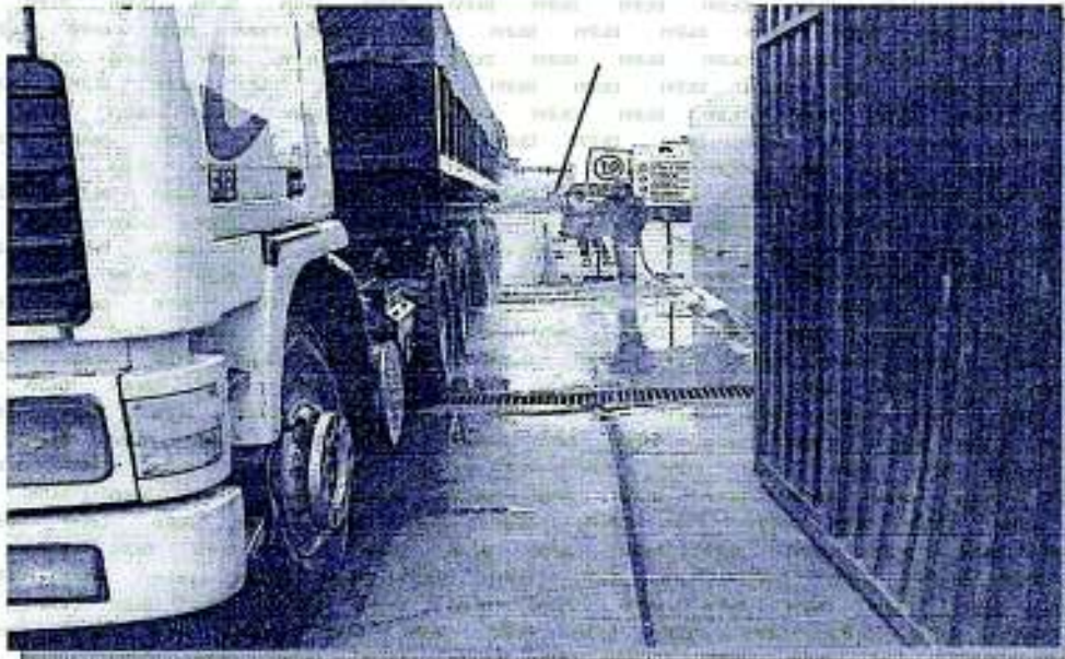
FOTO N° 15: Baja presión de agua en los aspersores después de un tiempo de funcionamiento, obsérvese al personal lavando con manguera partes del camión que no fueron alcanzadas por los aspersores.
