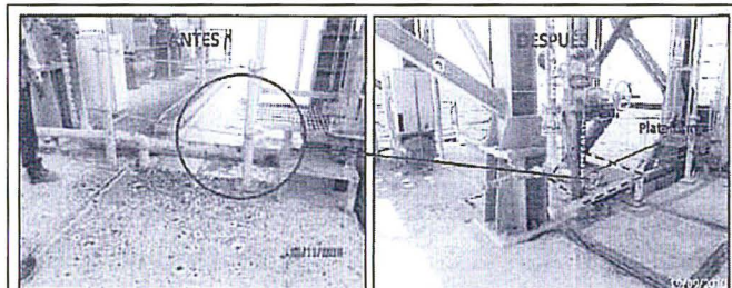
Imágenes 8 y 9. La imagen de la izquierda corresponde al momento de la supervisión (25.11.2016) y en la de la derecha se observa la plataforma metálica (9.09.2018). Coordenadas de ubicación de la toma fotográfica (UTM Zona 17 WGS84): 494414 E – 9359099
