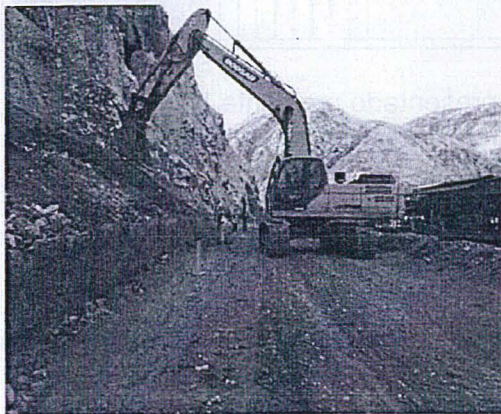
VISTA DE LA ZONA SUR EN PROCESO DE TRABAJO
