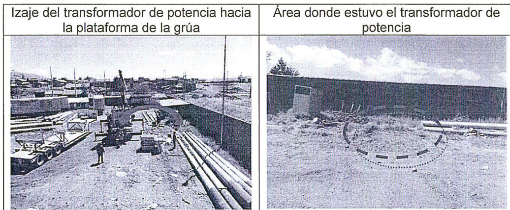
Imagen N°. 1. Vista panorámica del movimiento del transformador de 5000 kVA
