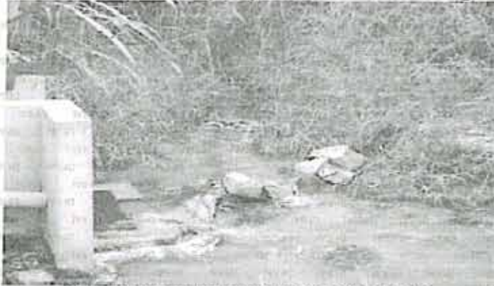
Canal de regadío y tubería de captación de agua
