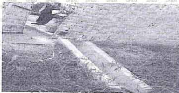
Salida del efluente hacia el canal de riego
