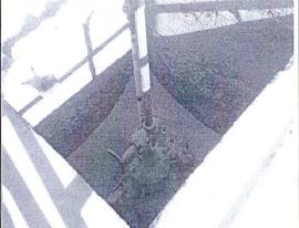
Foto N° 74. Coordenadas UTM Sistema WGS84 471863E 9526527N / Batería 2 el Pozo H-38 su cantina no se encuentra impermeabilizada, además de encontrar arena en su interior
