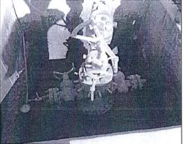
Foto N° 76. Coordenadas UTM Sistema WGS84 471824E 9526524N / Batería 2 el Pozo 123 su cantina no se encuentra impermeabilizada, además de encontrar arena en su interior.
