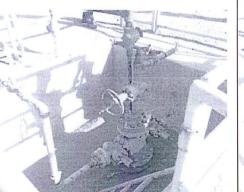
Foto N° 81. Coordenadas UTM Sistema WGS84 471893E 9527371N / Batería 3 el Pozo 1220 su cantina no se encuentra impermeabilizada, además de encontrar arena en su interior.
