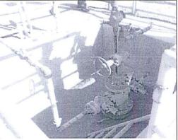
Foto N° 83. Coordenadas UTM Sistema WGS84 473488E 9530096N / Batería Rincon el Pozo R37-2A su cantina no se encuentra impermeabilizada y sus paredes se encuentran deteriorados, además de encontrar arena en su interior.
