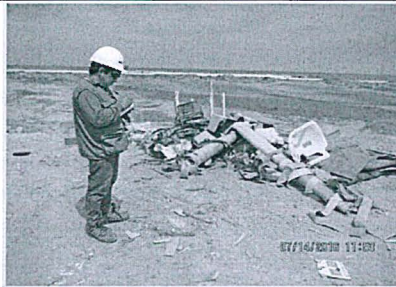
FOTO N° 36: ENTORNO DEL ALMACEN TEMPORAL DE RESIDUOS (ATR). Se observó residuos no peligrosos, plásticos y chatarrera mezclados y dispuestos sobre suelo en la parte exterior del almacén temporal de residuos (ATR). Coordenadas UTM (WGS84), Zona 17, 0485017, 9457026N
