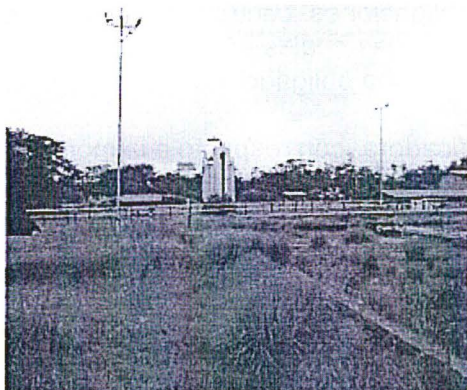
Foto N° 1: Batería 2 – Corrientes. Se observa vista panorámica del tanque N° 1M60S de techo fijo. Coordenadas UTM (WGS84): 0492816E, 9576867N
