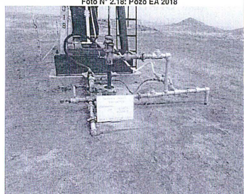
Se observa Pozo EA 2018 – PU – Batena OR-11 – Sin Cantina. Coordenadas UTM (WGS84), Zona 17: 9533060N, 484160E
