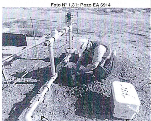
Se observa Pozo EA 6914 – PU – Batena BA34 – Sin Cantina. Coordenadas UTM (WGS84), Zona 17: 9530795N, 479435E
