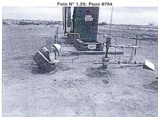
Se observa Pozo EA 8784 – PU – Batena BA35 – Sin Cantina. Coordenadas UTM (WGS84), Zona 17: 9529527N, 481066E
