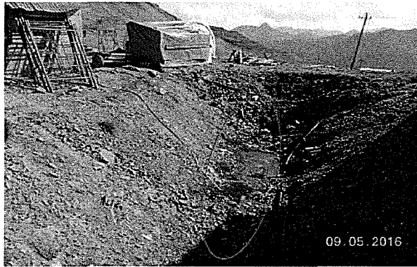
Fotografía N° 11: Vista fotográfica en el área de almacenes auxiliares, donde se observó flujo de agua de contacto que proviene de los pasivos, el cual atraviesa por el alcantarillado que se encuentra con residuos sólidos y se dirige sobre la cobertura vegetal esparciéndose por toda el área, ubicado en coordenadas UTM WGS 84; E 370 474, N 8 716 251.
