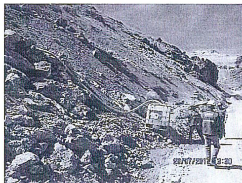
Fotografía N° 14. Se observa a los supervisores de OEFA, constatando los trabajos de captación, colección y derivación de la filtración de aguas.
