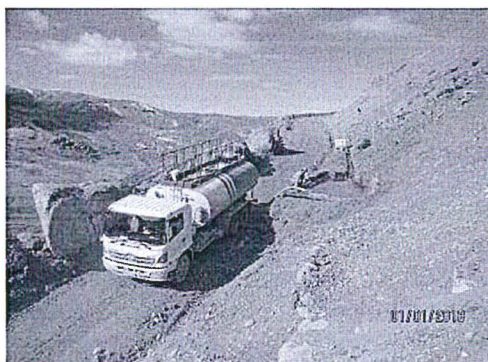
Fotografía N° 26. Se observa al operador de la sistema de agua, el mismo que realiza el trabajo de succión de agua de la poza que capta el ínfimo caudal de la filtración de agua del talud colindante a las pozas de geotextil.
