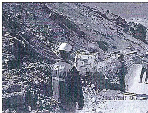
Fotografía N° 13. Se observa a los supervisores de OEFA, constatando los trabajos de captación, colección y derivación de la filtración de aguas.
