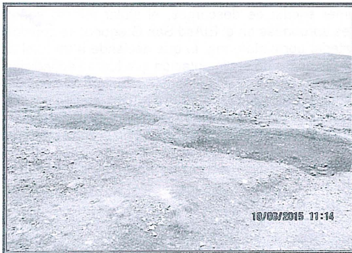
Fotografía N° 50: La fotografía muestra las pozas de sedimentación y el material de corte extraído en la plataforma 13.
