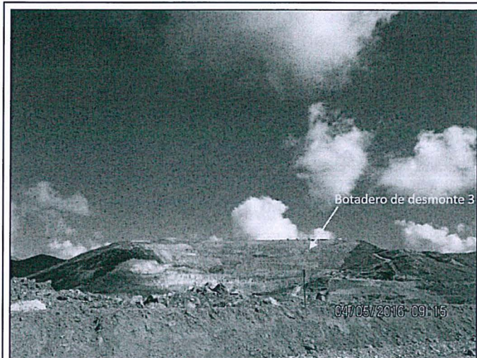
Fotografía N° 61. Vista de Botadero de desmonte 3 ubicado en las COORDENADAS UTM WGS84: 8829828N, 366852E. ZONA 18. Hallazgo N° 02.
