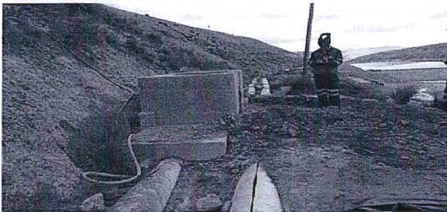
FOTOGRAFÍA N° 35.- Otra foto de la caja de paso 1: Caja de concreto, además se aprecia (lado izquierdo, tubería color negro) la línea actual de conducción de relave (grueso)
