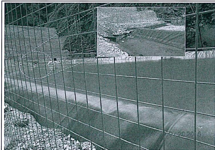
Fotografía N° 33: Deposito de relave El Porvenir, otra vista de la poza de subdrenaje revestido con geomembrana, el agua captada era enviado por rebose hacia el río Lloclla.
