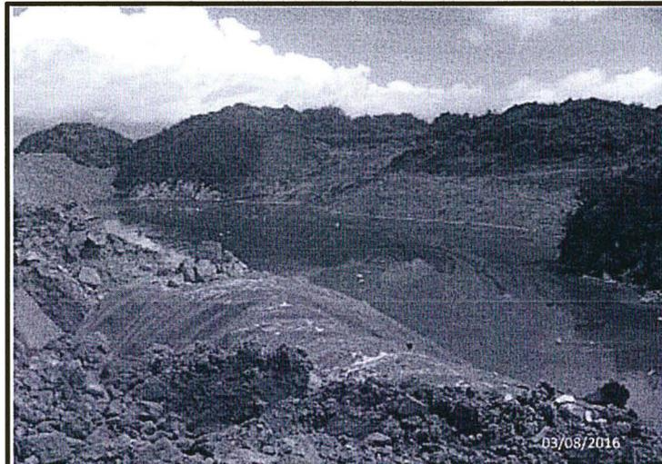
Fotografía N° 84: Hallazgo N° 1. En el depósito de desmonte DME Pampa Verde, con coordenadas UTM WGS 84 E-730139, N-9245329, se observó un área con disposición de lodos que provendrían del tratamiento de aguas ácidas en la Planta Pampa Verde.
