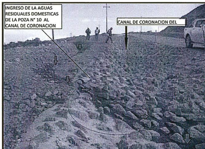
Fotografía N° 88: Hallazgo N° 2. Vista del canal de coronación del PAD de lixiviación, donde se puede observar el ingreso de las aguas residuales
