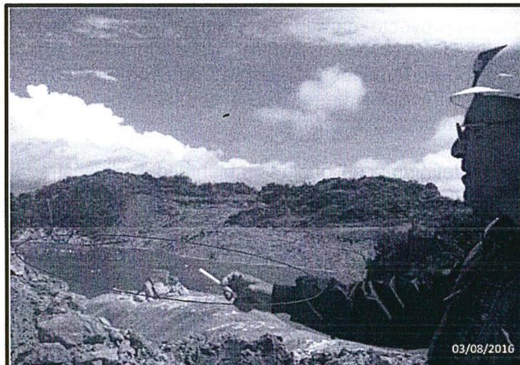
Fotografía N° 85: Hallazgo N° 1. Verificación de la disposición de lodos por el supervisor del OEFA donde se puede observar que el vaso no se encuentra revestido con geomembrana.
