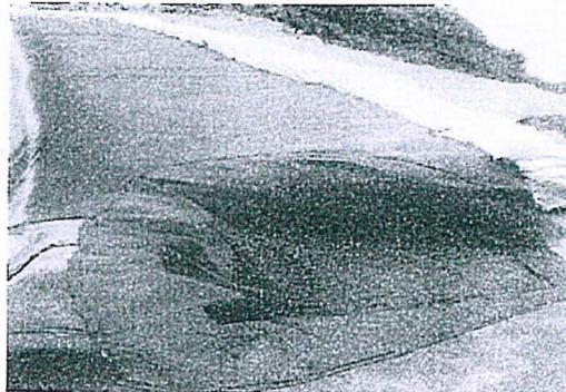
Imagen 4: Canal de rebose de la poza 6 A (ubicada al final del canal norte) se aprecia sellado por termofusión, no hay rebose al medio ambiente.
