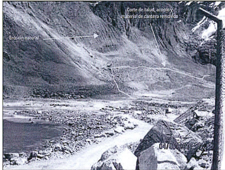
Fotografía N° 7.- Vista fotográfica del acceso a la zona removida (cantera).
