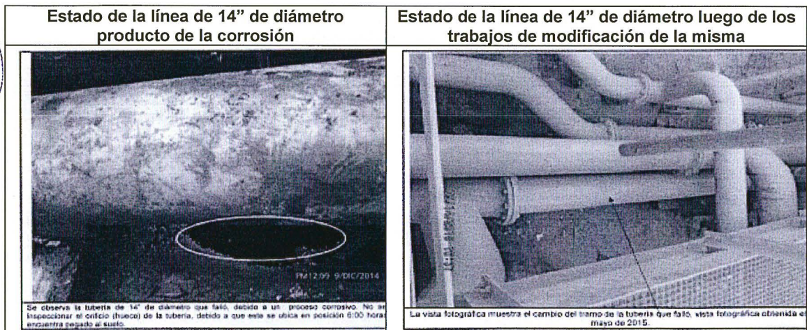
Gráfico N° 2: Cambio de la línea de 14" de diámetro
