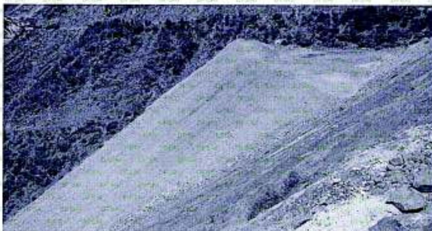
Foto 11: Talud y plataforma del depósito de desmorte en la bocamina del Nv 4000.
