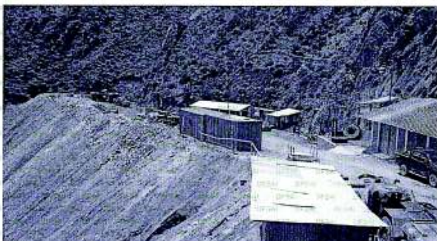
Foto 12: Plataforma del depósito de desmontes en la Bocamina 4400, no hay canal de coronación, las aguas del flanco derecho son derivadas por la cuneta de la vía de acceso.
