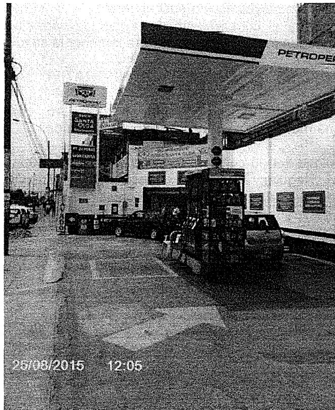
Fuente: Escrito de descargos del administrado, con H.T. N° 81403.
