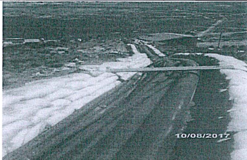
Foto N° 13: Canal de contingencia donde van ubicadas las tuberías de relleno y otras tuberías (efluente industrial)
