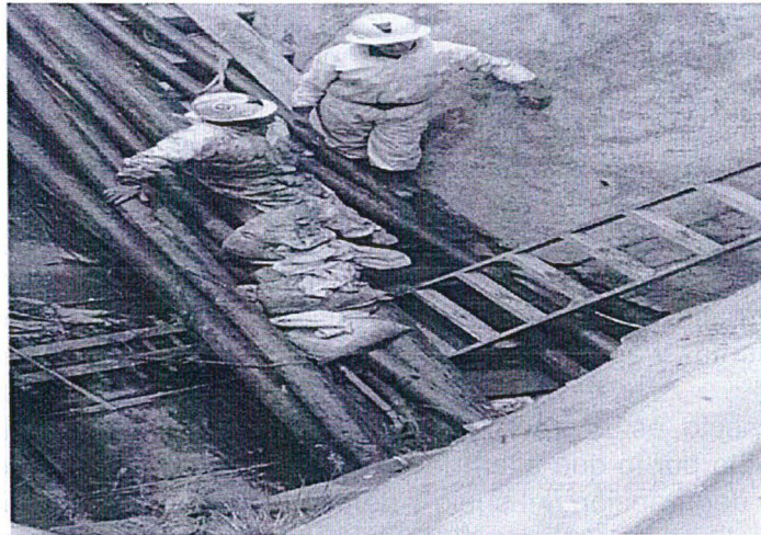
Foto N° 01 En las coordenadas E 0344366 y N 8780444 se realizó la evacuación de costales con relave del Túnel Linner Fuente: Minera Chungar (Escrito de descargos)
