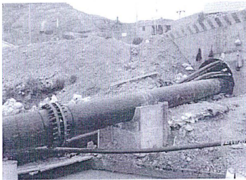
Foto N° 01: En las coordenadas E 0344397 y N 8780458 Antes de la construcción del canal relleno hidráulico
