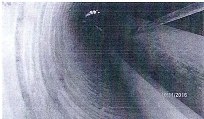
Foto N° 03: Se realizó la limpieza del relave del túnel Linner. Fuente: Minera Chungar (Escrito de descargos)
