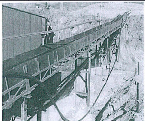
Foto N° 08 En las Coordenadas E 0344424 y N 8780775 se construyó un puente de estructura metálica para la contingencia y evitar derrame en el trayecto de las tuberías de relleno hidráulico.
