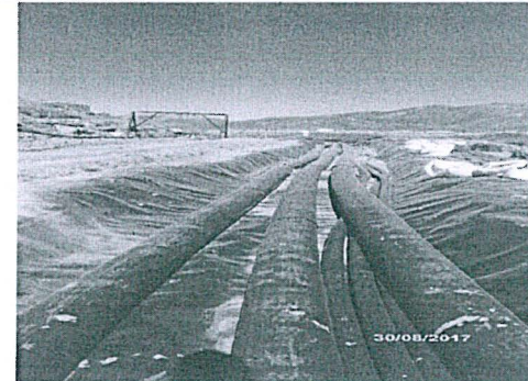
Foto N° 10 En las coordenadas E 0344476 N 8780572 se observa tubería de relleno de hidráulico en el canal de contingencia
