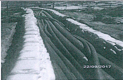
Foto N° 14: Canal de contingencia en todo el trayecto de recorrido de las tuberías
