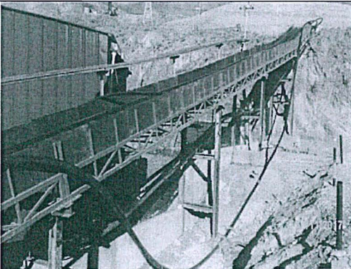
Foto N° 15: En las Coordenadas E 0344424 y N 8780775 se construyó una estructura metálica de contingencia para evitar derrame en el trayecto de las tuberías de relleno hidráulico.
