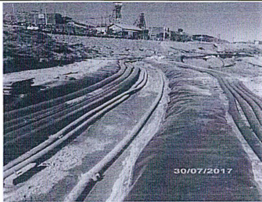
Foto N° 17: En las Coordenadas E 0344476 y N 8780572 Estandarización de las tuberías de relleno hidráulico
