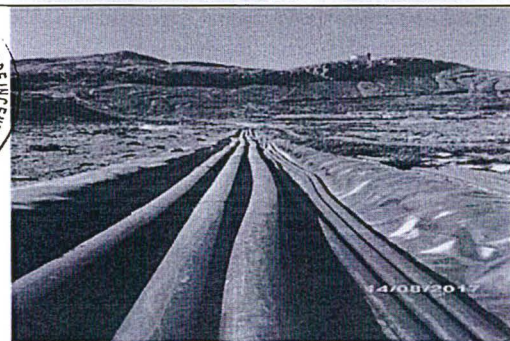
Foto N° 19: Se realizó la limpieza de relave en las pozas de contingencia
