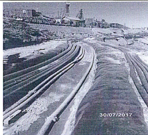
Foto N° 09 En las Coordenadas E 0344476 y N 8780572 de las tuberías de relleno hidráulico en el canal contingencia
