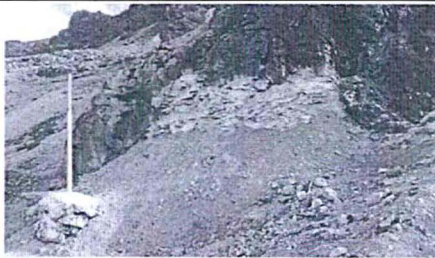
Fotografía N° 13: Relleno de bocamina B-AD-18 utilizando desmonte de desmontera D-AD-23
