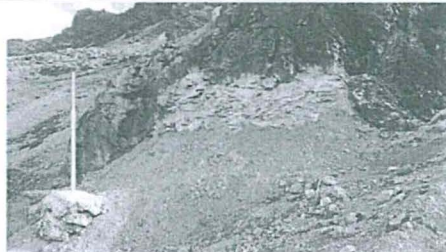
Fotografía N° 13: Relleno de bocamina B-AD-18 utilizando desmonte de desmontera D-AD-23
