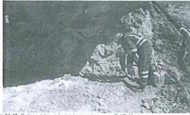
Fotografía N° 15: Relleno del portal y tapón de la bocamina B-AD-18 utilizando desmonte de desmontera D-AD-23
