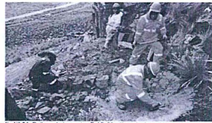
Fotografía N° 04: Relleno de bocamina B-AD-20 utilizando desmonte de desmontera D-AD-20
