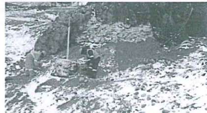
Fotografía N° 12: Relleno de bocamina B-AD-18 utilizando desmonte de desmontera D-AD-23
