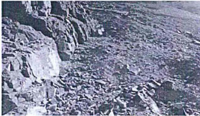
Fotografía N° 13: Cierre final de la bocamina B-AD-17, en la cual se utilizó como relleno el desmonte de la desmontera D-AD-22
