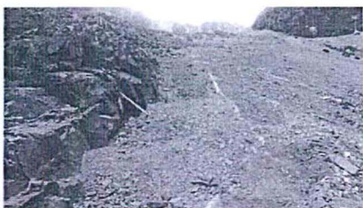
Fotografía N° 12: Relleno de bocamina B-AD-17 utilizando desmonte de desmontera D-A
