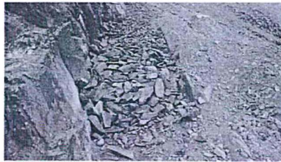
Fotografía N° 11: Relleno de bocamina B-AD-17 utilizando desmonte de desmontera D-A
