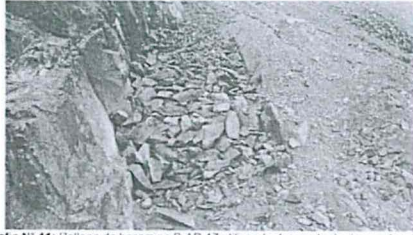
Fotografía N° 11: Relleno de bocamina B-AD-17 utilizando desmonte de desmontera D-AD-22
