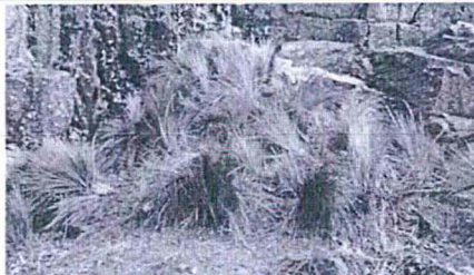
Fotografía N° 05: Cumplimiento del cierre de la bocamina B-AD-20, utilizando desmonte de la desmontera D-AD-20 como relleno y posteriormente colocando cobertura vegetal.
