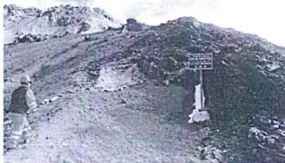
Fotografía N° 09: Vista del relleno (utilizando desmonte de desmontera D-AD-21) y coberturado de bocamina B-AD-19
