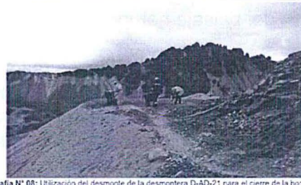
Fotografía N° 08: Utilización del desmonte de la desmontera D-AD-21 para el cierre de la bocamina B-AD-19
