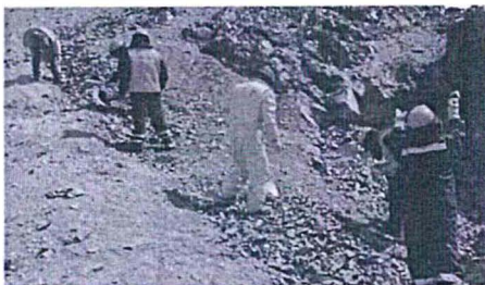
Fotografía N° 07: Relleno de bocamina B-AD-19 utilizando desmonte de desmontera D-AD-21
