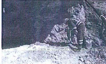
Fotografía N° 15: Relleno del portal y taponé de la bocamina B-AD-18 utilizando desmonte de desmontera D-AD-23
