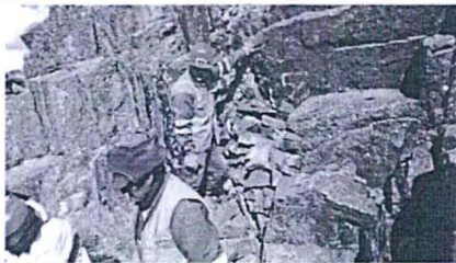
Fotografía N° 03: Relleno de bocamina B-AD-20 utilizando desmonte de desmontera D-AD-20
