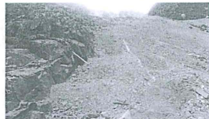
Fotografía N° 12: Relleno de bocamina B-AD-17 utilizando desmonte de desmontera D-AD-22
