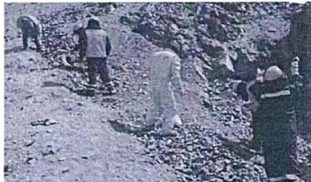
Fotografía N° 07: Relleno de bocamina B-AD-19 utilizando desmonte de desmontera D-
