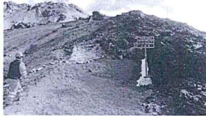
Fotografía N° 09: Vista del relleno (utilizando desmonte de desmontera D-AD-21) y corroborado de bocamina B-AD-19
