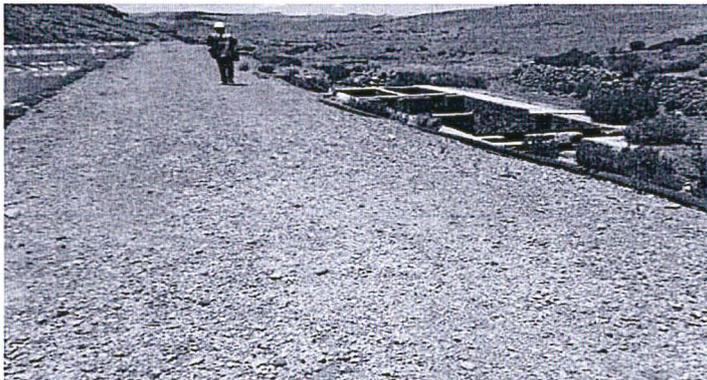
Fotografía N° 125: Hallazgo N°1: El sistema de tratamiento de agua proveniente de la bocamina B-10 ha sido construido sobre el Depósito de desmonte DD-04 (Antigua escombrera E-8). Así mismo, dentro del área de dicho depósito se encuentra una estructura de concreto y una poza de concreto.
