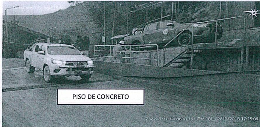
Operación del Lavadero de Vehículos de San Andrés, lavado de camioneta con hidrolavadora; nótese la pendiente negativa del sedimentador (8%) y giba, así como los sardineles tanto en la rampa como en la zona de espera de vehículos.
