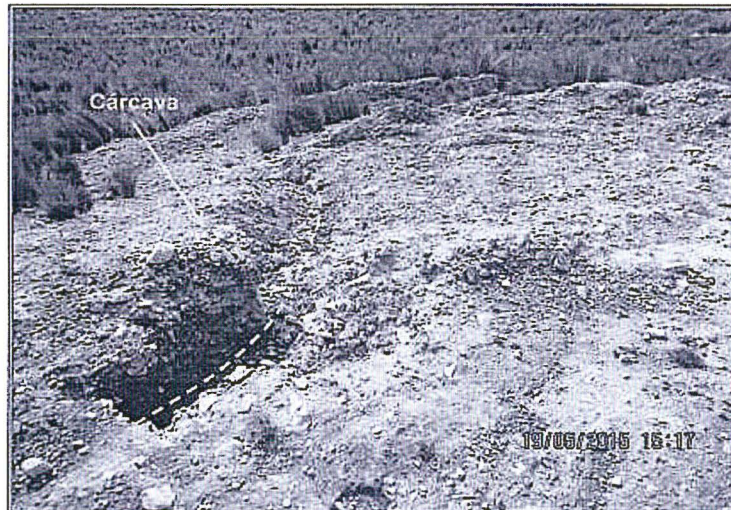
Fotografía N° 126: Vista de la Plataforma (sondaje AHAD 256) con presencia de cárcavas.
