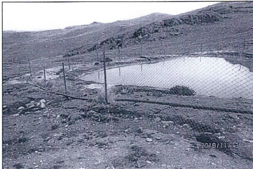
Fotografía N° 2: Derivación del agua de subdrenaje del botadero de desmontes, se observa que no existe ninguna mezcla de aguas, las descargas son independientes
