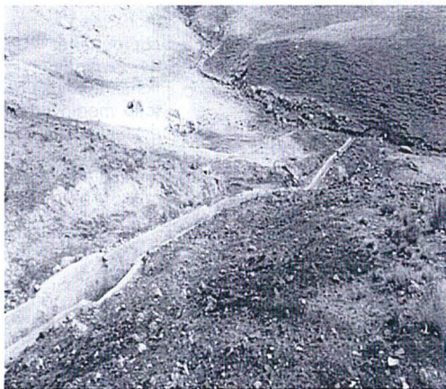
Figura 2. Canal de mampostería para la descarga del efluente QCH-1
