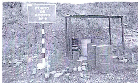
Fotografía N° 105: HALLAZGO N° 1: En el punto de acopio de residuos sólidos N° 9, ubicado en la parte baja del taller de mantenimiento mecánico se observó 02 cilindros conteniendo aceites lubricantes usados que se encontraban fuera de la zona de acopio y dispuestos sobre el suelo. Coordenadas UTM Datum WGS84: 8898522 N y 2703611 E.
